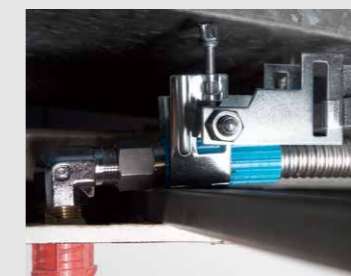
ダクト下用金具施工例
