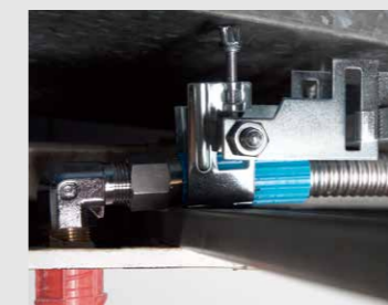
ダクト下用金具施工例
